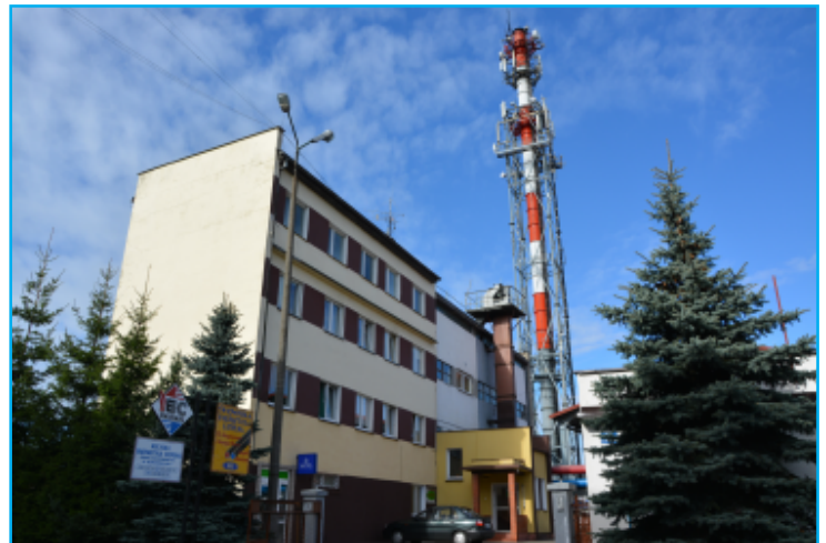
Nichtraucher: Das Heiz-Kraftwerk – mitten in der Stadt Gleich neben sauberen Wohnblocks, ein kohlebetriebenes Heizkraftwerk, städtisch. Dank guter Filteranlagen offensichtlich ohne Rauchentwicklung, Umweltbelastung und Nachbarschafts-Klagen
